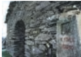
5 Triacastela es una pequeña localidad con todos los servicios y en la cual el Camino se divide en dos ramales que se juntan cerca de Sarria
