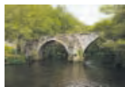
6 El puente de San Alberte, que da acceso a la iglesia homónima con una fuente llena de tradiciones. Fueron reformados hace poco
