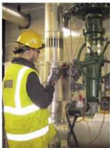
**Prueba de válvula de control**
