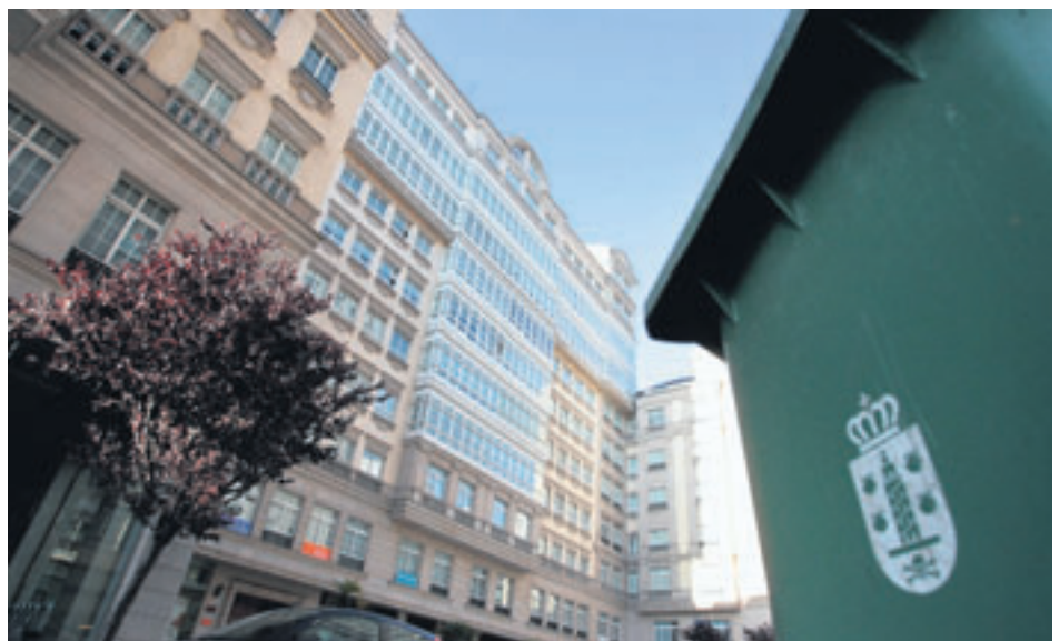
El edificio Conde de Fenosa, sobre el que pesa una orden de demolición, está en la calle Fernando Macías. ÓSCAR PARÍS
