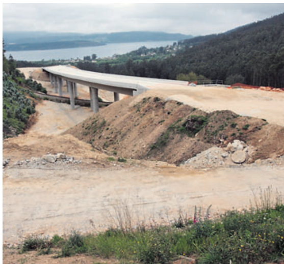
Obras del corredor sin maquinaria ni obreros en Xove. PEPA LOSADA
